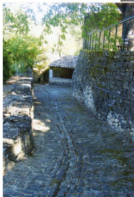
La calade menant au premier lavoire, celui du bas.
