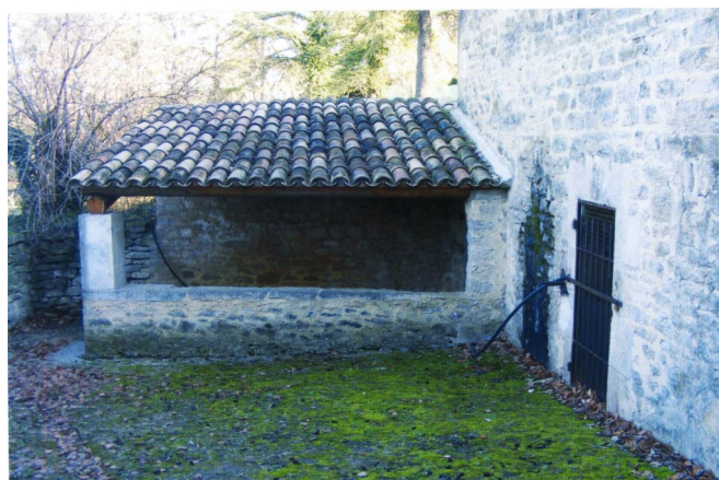
Le lavoir du bas. A droite, la porte de la citerne .
